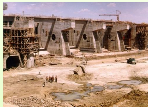
1. ábra. A Kiskörei-vízlépcső építése
